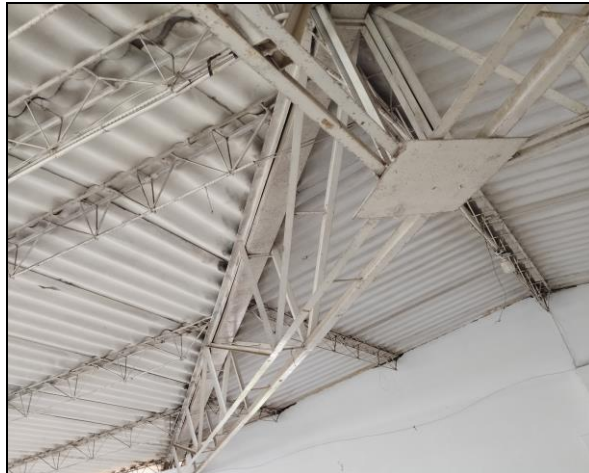
Error constructivo en transmisión de cargas de correa a cercha
